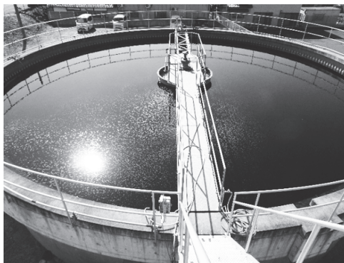
写真15、写真16：バクテリアによる汚泥活性処理の様子(屋上)
