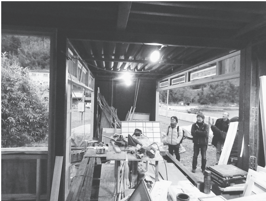
写真 6 : 浜に設えられた工房
