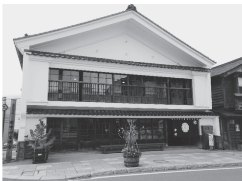
写真12 旧中村家住宅の主屋側正面
