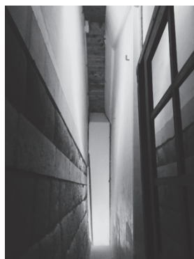
写真13 通り庭から見る文庫倉（左）と下ノ倉（右）の狭間
