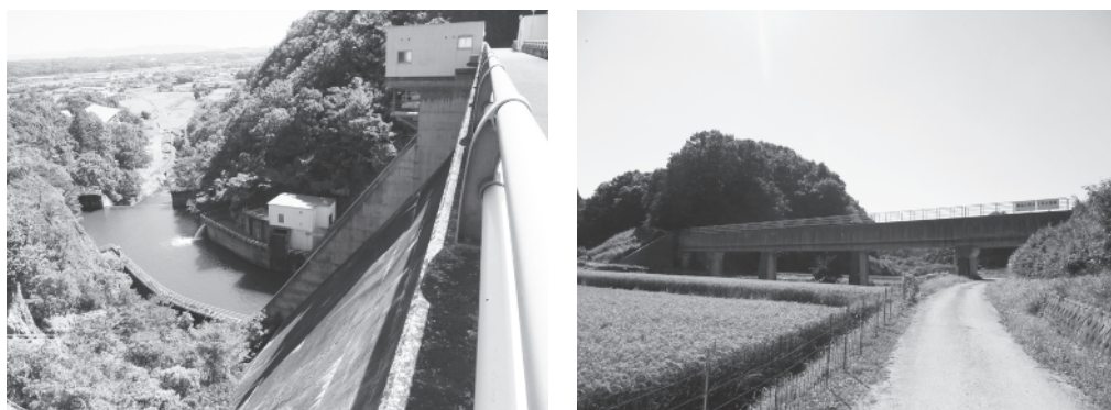
(写真左) 鴨川ダム (写真右) 1号幹線水路橋
