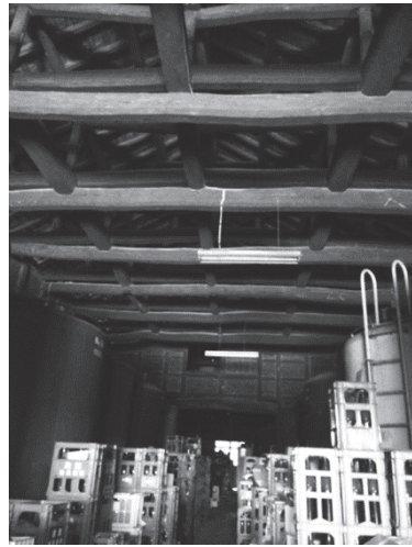
写真 11 酒蔵内部の立派な梁
