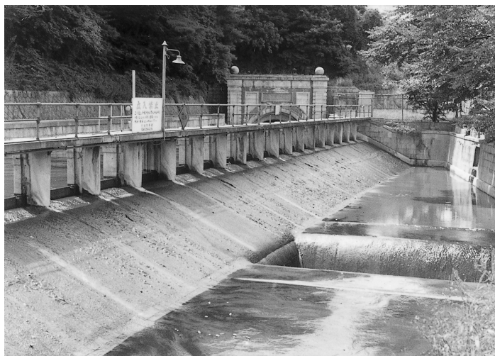
写真 6-4 蹴上上水の発電所（取水口）
