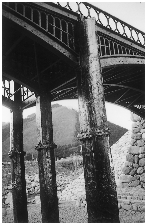
写真 4-12 生野に現存する鑄鉄橋の一つ
