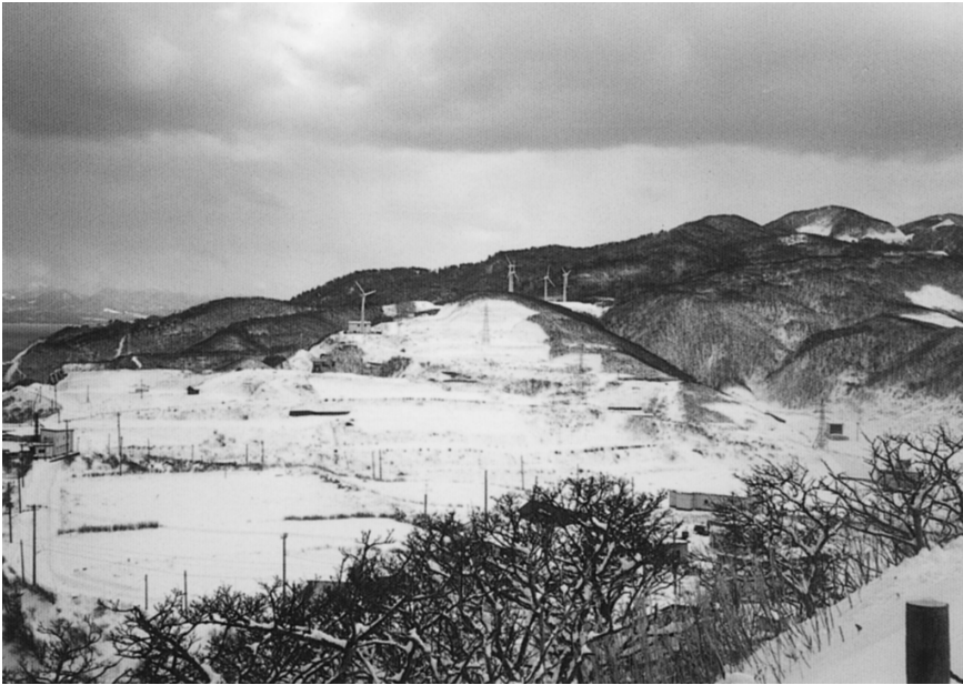
写真 20 竜飛崎風力発電所全景
