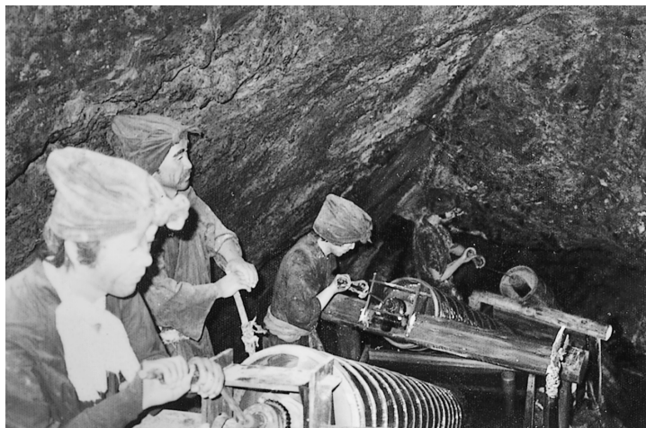
写真1 佐渡における水上輪による排水
