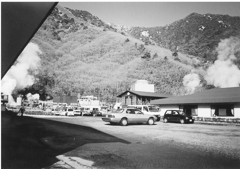
写真 30 九重観光ホテルの自家発電風景（地熱発電）
