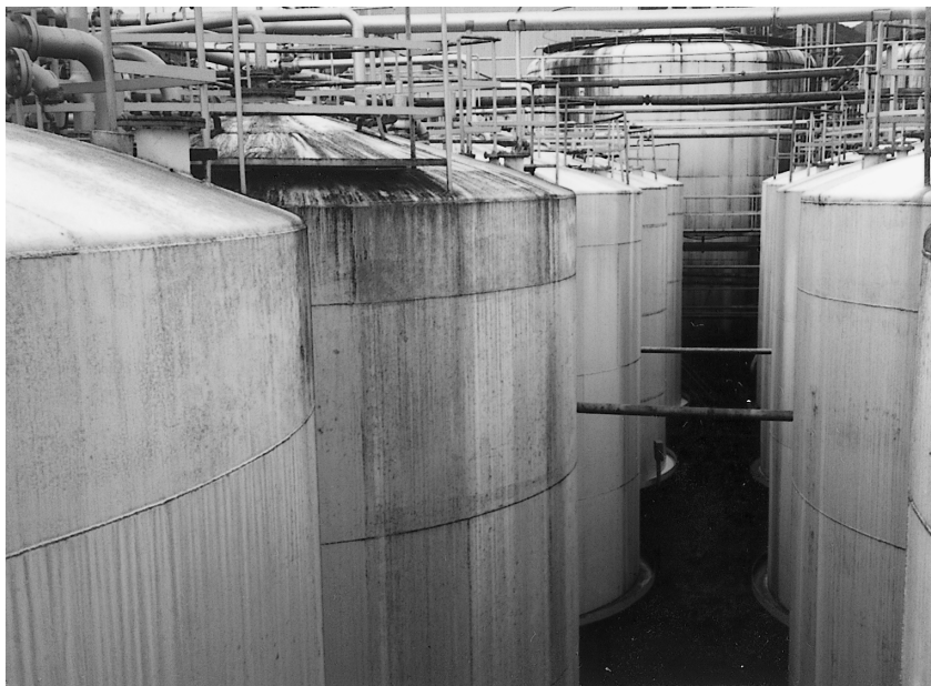
写真 38 出水アルコール工場 装置群
