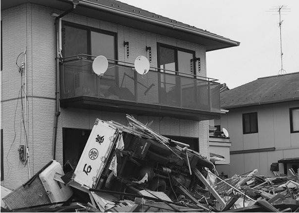
写真5 渡波（一階にはトラックが流れ込んだ民家）
