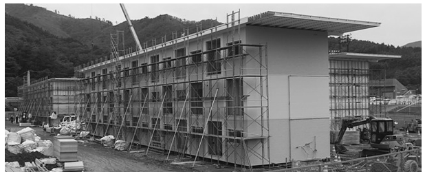
写真20 女川の多層コンテナ仮設住宅
