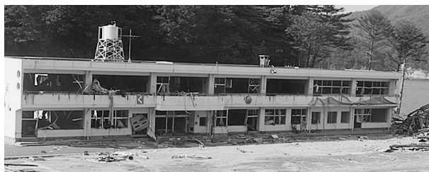
写真11 石巻市立谷川小学校
