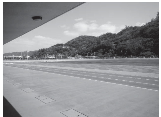
写真8. 国頭陸上競技場内
