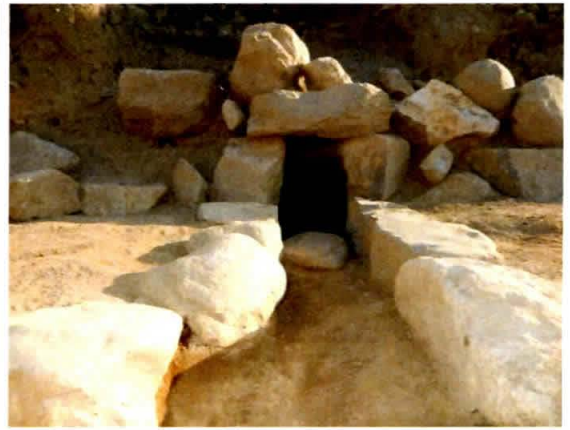
図 77 慶州財貫井址水庫の出水口
