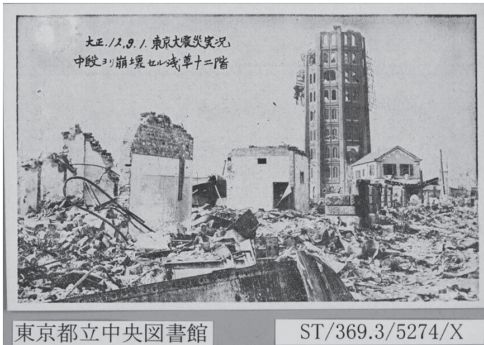
図6 絵葉書「大正十二年九月一日帝都大震災實況葉書 中段ヨリ崩壊セル浅草十二階」
