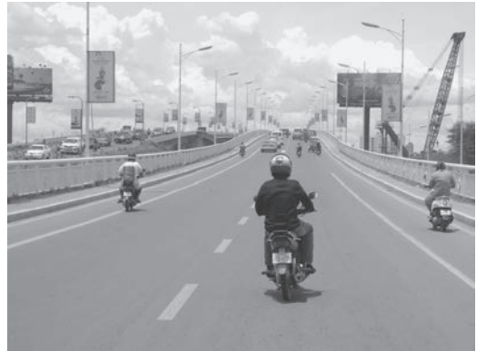
写真4—プノンペン郊外の橋
