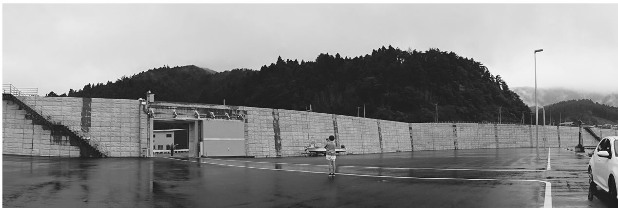
写真3 雄勝の防潮堤
