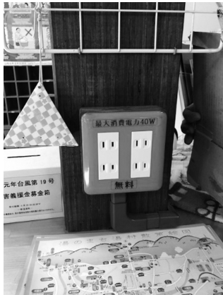
写真9 災害用コンセント
