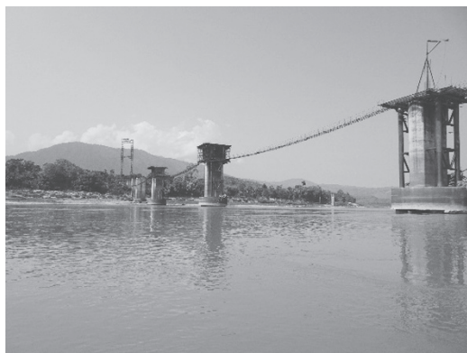
f. 中断したミッソングムの建設現場
