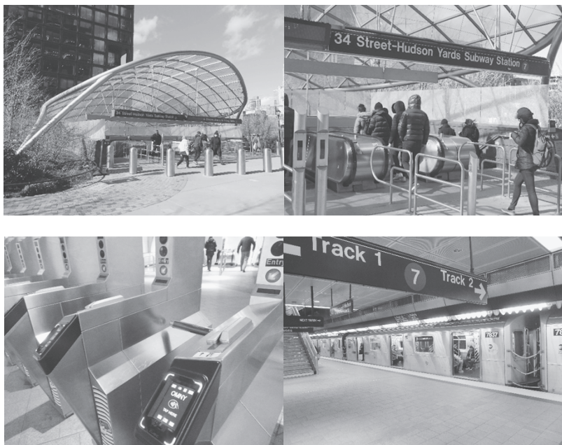
図表 13 ハドソンヤード再開発の一環として新規建設された地下鉄 7 番線の 新駅「34 ストリート・ハドソンヤード駅」
