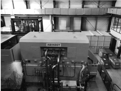
写真1 ヘトリスヘイジ発電所（東芝製蒸気タービン）
