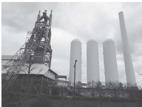
写真10：左が10代目の高炉、右が熱風炉
