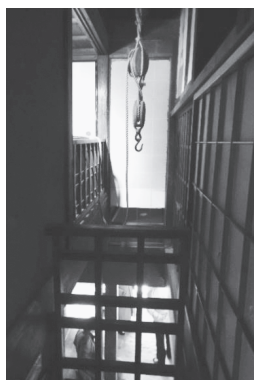
写真 17：一階から仕入れ荷物を滑車で吊り上げる
