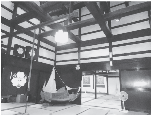
写真 14：オイの間から梁を見上げる
