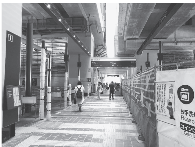
写真 12：左手は路面電車終点富山駅、右手は LRT への平面接続のために工事中
