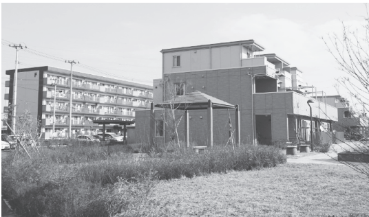
写真5：新興街区・蛇田の復興公営住宅
