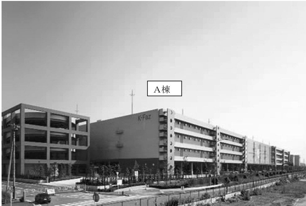
写真3 かわさきファズ物流センターA棟
