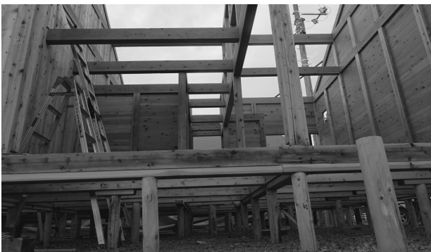
写真18 いわき市高久から総社市に移設中の板倉構法の木造仮設
