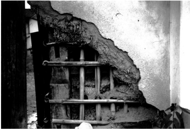
写真－2 漆喰壁の構造
