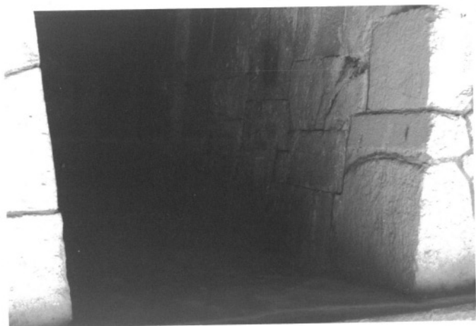
写真－1 石室の隙間に詰められた漆喰
